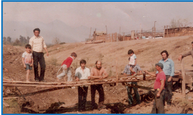
Construcción de puente sobre el Zanjón de la Aguada, primera mitad de la década del 80.
