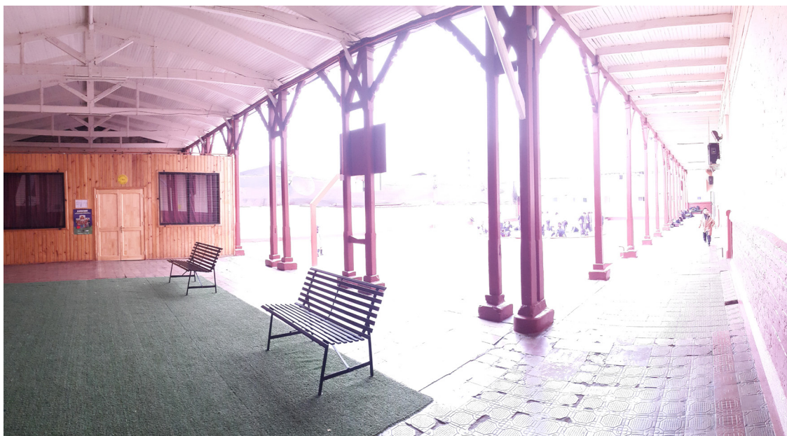
Corredor escuela para hombres, año de construcción 1913
