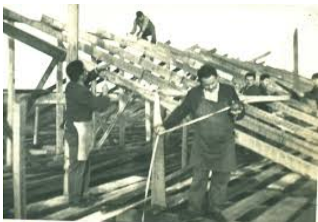
Foto del proceso de construcción de las casas de la Cooperativa Techo para Todos
