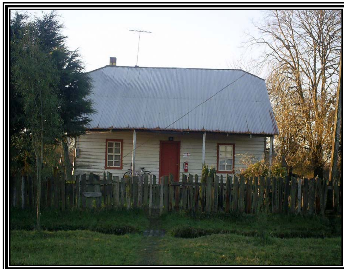
Vivienda construida en tiempos de la Hacienda Ñuble-Rupanco.
