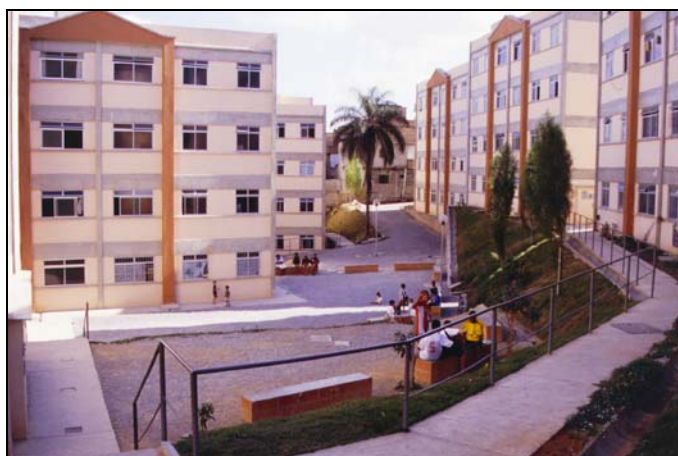
Conjunto de Viviendas Belo Horizonte. 192 Unidades
